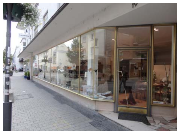
Filigran wirkende Schaufensterkonstruktion im Ursprungszustand
