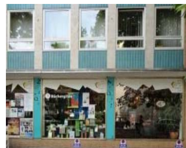
Durch Werbefolie nicht mehr nachvollziehbare Fassaden- bzw. Gebäudestruktur
