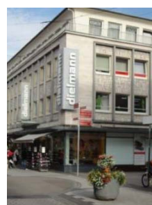
Naturstein bzw. Keramikplatten als Fassadenverkleidung
