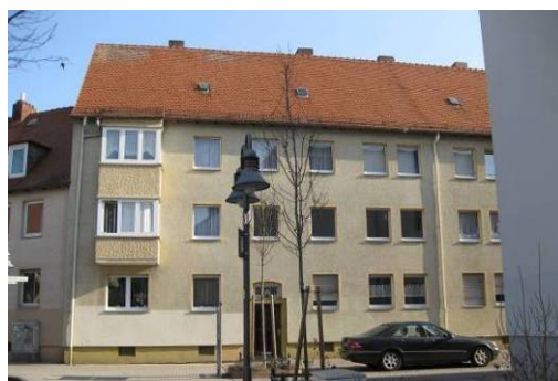
Louise Schröder-Straße – Wiederaufbauphase 1950er Jahre
