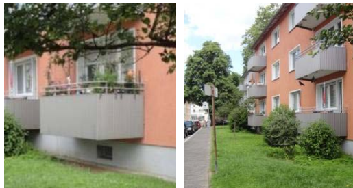
Entsprechend dem 50-ger Jahre Duktus der Häuser: feingegliederte – gewellte Metallprofile an den Balkonbrüstungen
