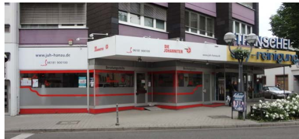
Nicht mehr einsehbare Schaufensteranlagen
