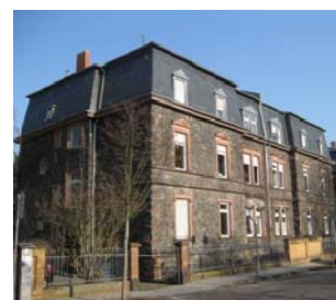
Kulturdenkmal mit einer Natursteinfassade
