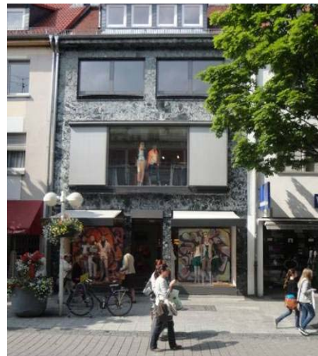
In die Fassade integrierte Kombinationen von Gelenkarm- und senkrechten Markisen
