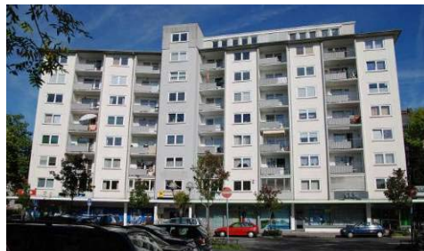
Flächig in die Fassade integrierte Loggien
