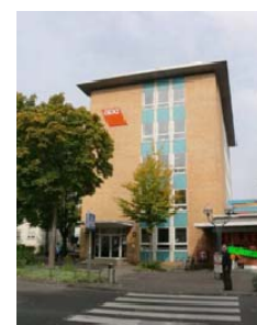
Sichtmauerwerk-Klinker in Kombination mit Betonwerkstein
