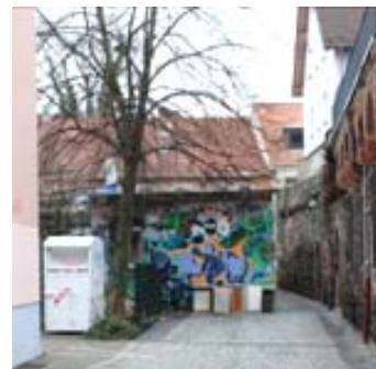
Serviceterminals ohne gestalterischen Bezug zum Gebäude-Strassenraußes
