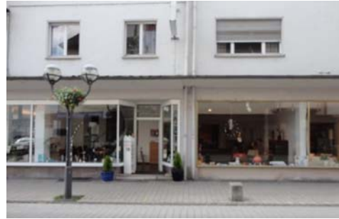
Positiv 2 Häuser mit einer Vordachkonstruktion Unterschiedliche Wirkung von Aluminium- Schaufensterprofilen links und rechts zu den filigran wirkenden Stahlprofilen aus dem Ursprungszustand
