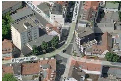
Bebauung Bangertstraße / Hospitalstraße
