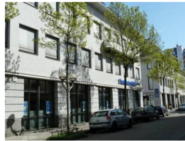
Positives Beispiel für eine glatte Putzfassade der Obergeschosse und Lisenen-Profilierungen im Bereich des Sockelgeschosses
