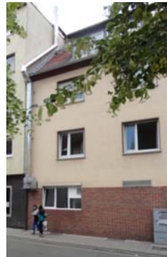
Verlegung der Küchenabluftleitung auf die Blockinnenseite wünschenswert
