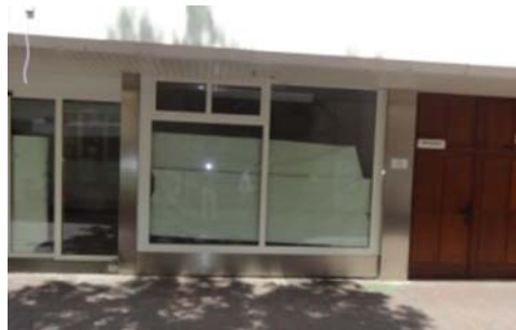
Papierverklebungen nur im Umbauzustand
