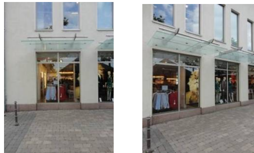
Filigran wirkende Vordachkonstruktion
