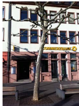
Verwendung von stark plastisch durchgearbeiteten Sandstein im Sockelgeschoss
