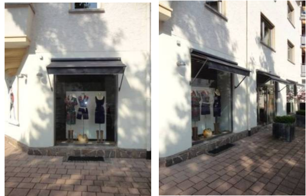
Gut in die Fassadestruktur integrierte Markisenkonstruktion
