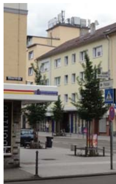
Die Dachfläche dominierende technische Aufbauten
