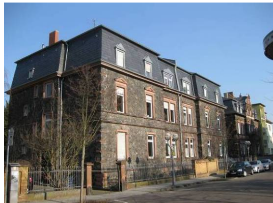
Eberhardstraße Doppelhaus Nr. 6 und 8, Dachausbau der denkmalgeschützten Gebäude. Das neue Dachgeschoß wirkt erdrückend im Vergleich zu der nebenstehenden Ansichtszeichnung.
