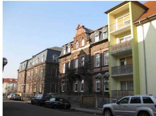
Eberhardstraße Nr. 4 (Mitte) Kulturdenkmal. Eberhardstraße Nr. 2 (Rechts) Neubau – der Neubau nimmt keine Rücksicht auf das Kulturdenkmal.
