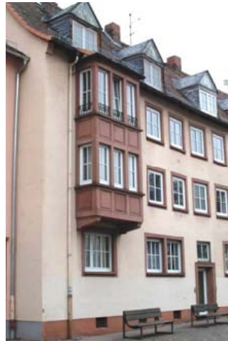
Beispiel Lochfassade (Franz. Allee)
